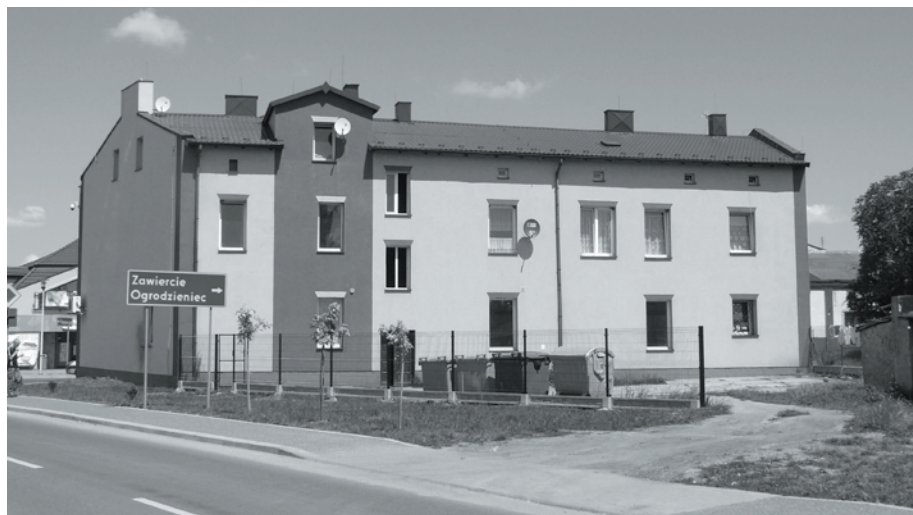
Odremontowany budynek wspólnoty przy ul. Kościuszki 34 w Łazach
